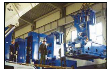
Монтаж лесопильной линии
