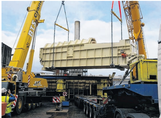
Die Positionierung der Maschine auf der Baustelle war Schwerstarbeit
