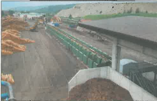
Die neue Abschnittsortieranlage bei Krenzer im Sägewerk Dorndorf. Nach dem Metallsuchband werden die Stämme 3-D vermessen und anschließend in die 52 Boxen absortiert.
