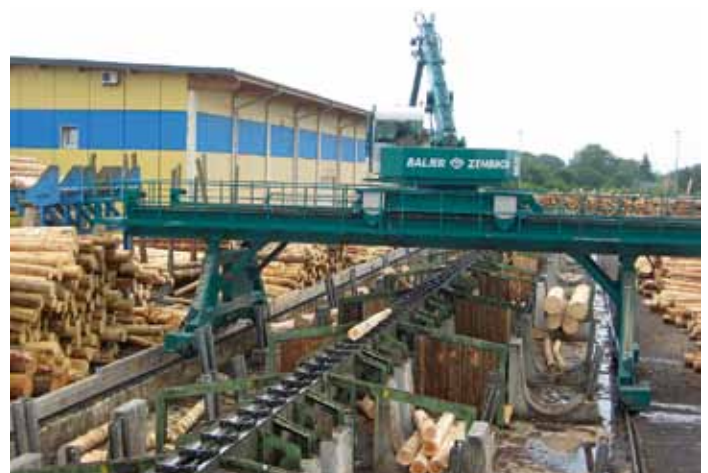
Mit dem Portalkran LGX ist eine zügige Sortierboxen-Entleerung, die Lagerung der Abschnitte und die Beschickung des Sägewerks gewährleistet
