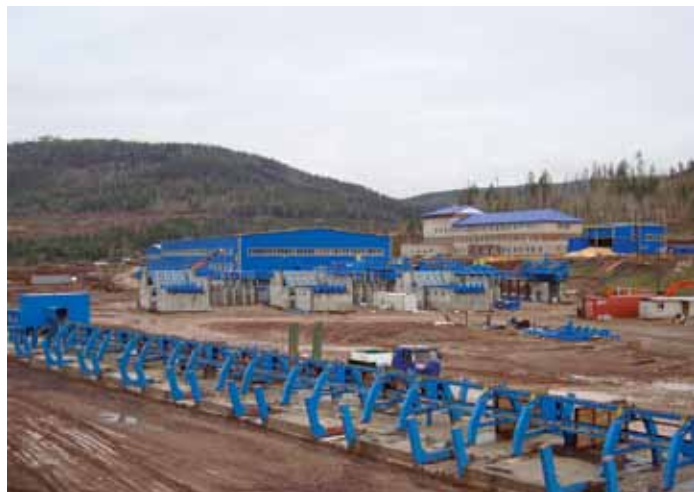
In 56 Boxen werden die Stämme sortiert, im Hintergrund sind die Rundholzaufgaben für die Sägelinien zu erkennen
