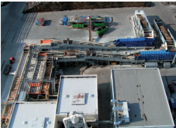
Holzplatzanlagen aus einer Hand: Komplett-Engineering vom Rundholzspezialisten für Kronospan
