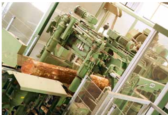
Die – mitunter sehr krummen – Stämme gelangen in der Linie zuerst zum Spaner VM 45
