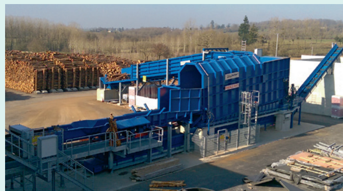
Pellets-Holzplatz von Holtec bei Bretagne Pellets während der Inbetriebnahmephase
