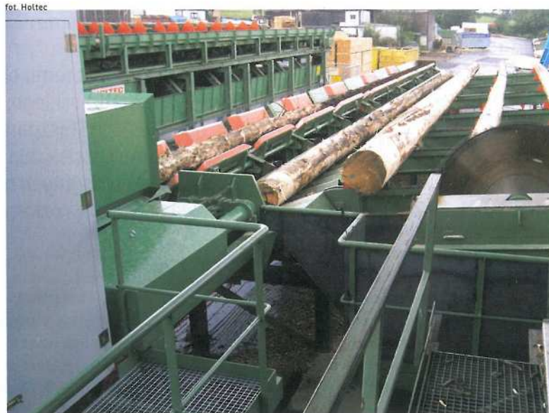
Linia dostarczona do tartaku Hüster przez firmę Holtec.
